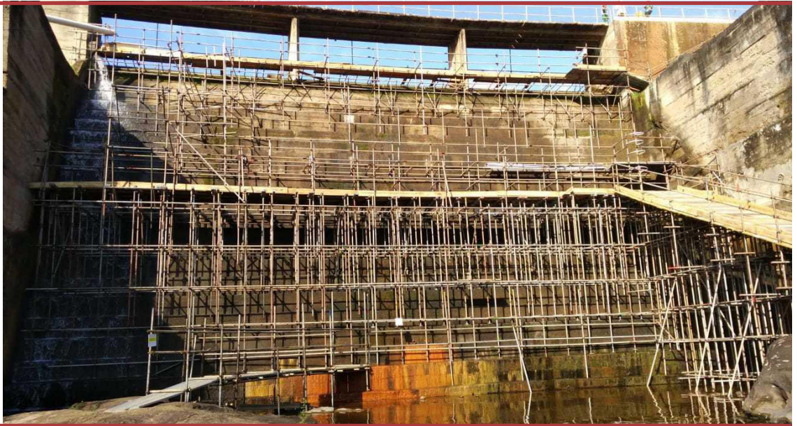
Barragem PCH Melo Rio Preto de Minas - MG
